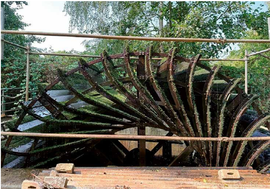
Abb. 6: Zuppinger-Wasserrad der Buchholzer Mühle
